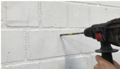
Verwenden Sie für die Löcher einen Bohrer mit 8 mm Durchmesser. Die Bohrlöcher sollten eine Tiefe von 45 mm aufweisen.
