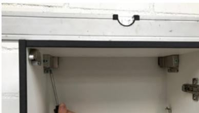
Richten Sie den Schrank mit den unteren Schrauben aus.
