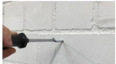
Platzieren Sie die Dübel in den Bohrlöchern und befestigen Sie die Wandhaken. Diese sollten nach Montage 20 mm herausragen.
