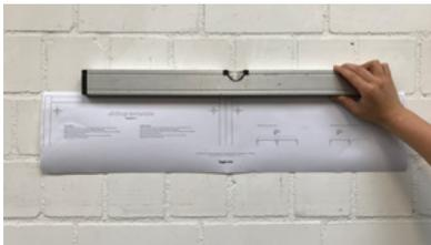
Verwenden Sie die mitgelieferte Bohrschablone, um die Position der Bohrlöcher festzulegen.
