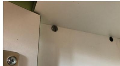
Platzieren Sie die Gewindehülsen in den entsprechenden Bohrungen und richten Sie die Schlitze vertikal aus.
